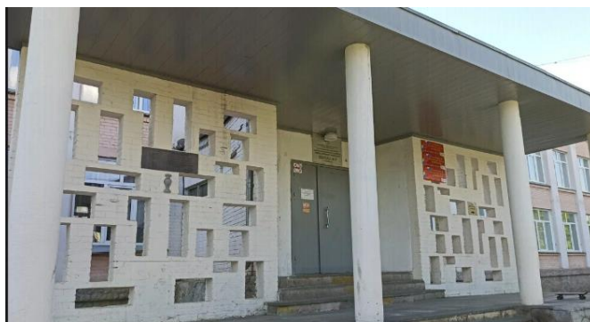
Фото 1. – Главный вход в школу
