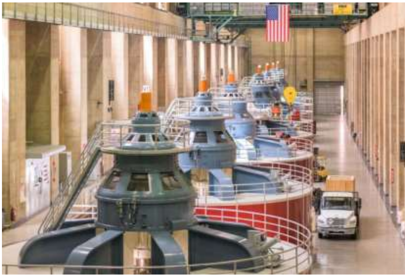
Рисунок 8. – Машинное отделение ГЭС «Hoover Dam» (штат Аризона, США)
